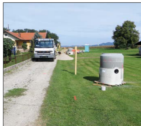
V naselju Gerečja vas poteka izgradnja hišnega priključka na odcepu »Vajda« v dolžini 140 m.
