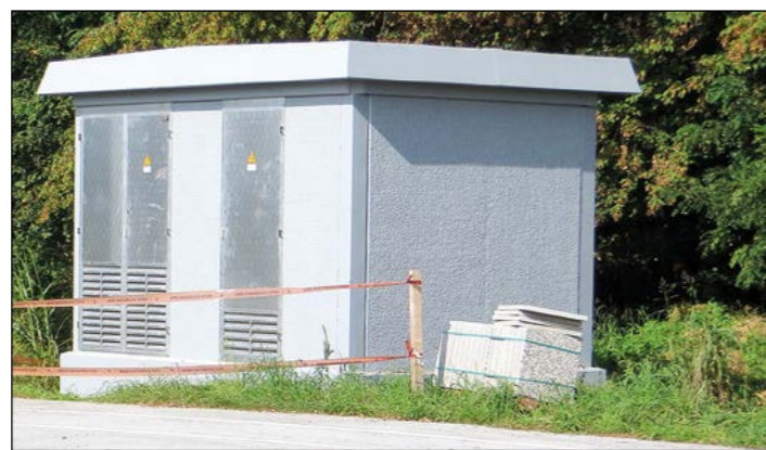
Nova transformatorska postaja v naselju Zg. Hajdina preko proge.
