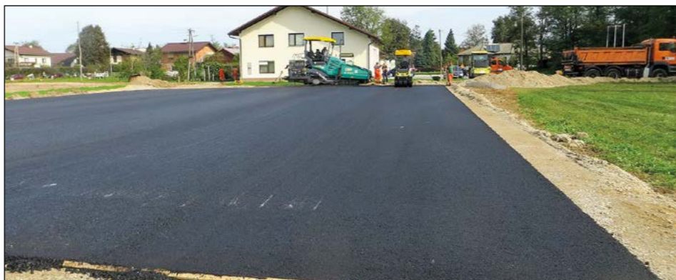
Ob Domu vaščanov Draženci je izgrajeno novo asfaltno parkirišče.
