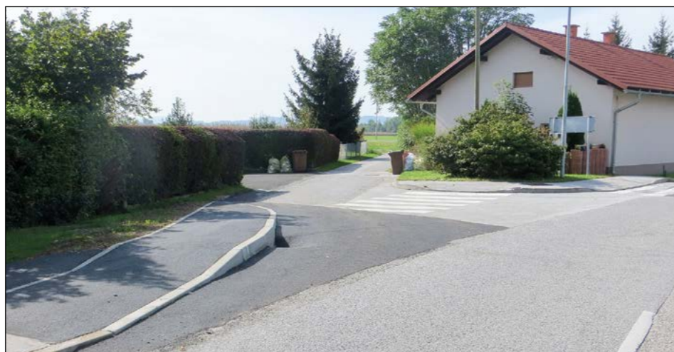
V naselju Spodnja Hajdina se je izvedla razširitev priključka poljske poti na lokalno cesto.
