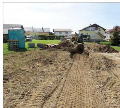
V naselju Gerečja vas poteka izgradnja hišnega priključka na odcepu »Vajda« v dolžini 140 m.
