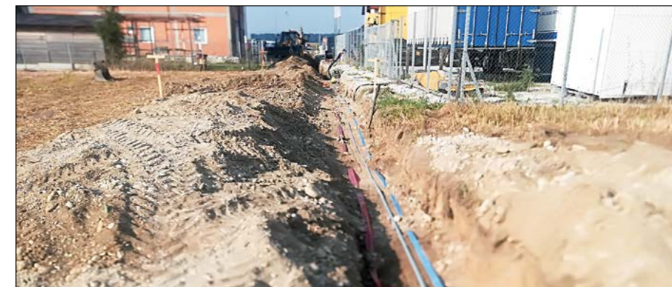
V Slovenji vasi, na odcepu Škrinjar–Kokol, so v sklopu asfaltiranja izvedli tudi odvodnjavanje meteornih voda z linijskim požiralnikom in ponikalnico.
