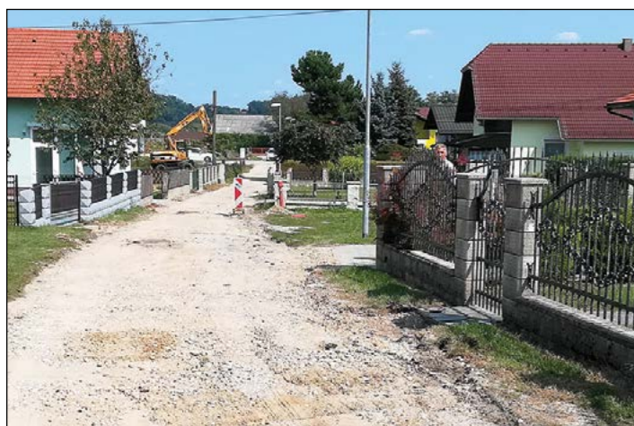
V naselju Hajdoše je bila zaradi posedkov po izgradnji kanalizacije nujno potrebna sanacija asfaltne ceste.
